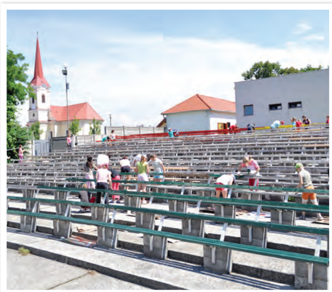
Práce pri obnove amfiteátra
