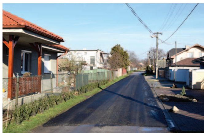
Rekonštrukcia miestnej komunikácie na ul. Budovateľská
